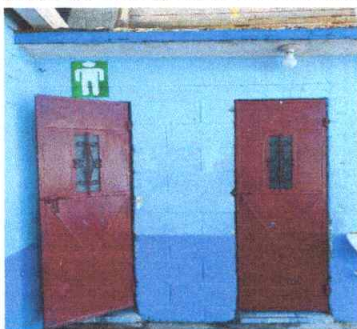
Foto 1: PUERTAS DE METAL: Sustitución de puerta en servicios sanitarios, MÓDULO 1
