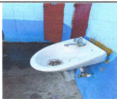
Foto 6: SERVICIOS SANITARIOS Y SUS ACCESORIOS: Sustitución lavamanos, MÓDULO 1
