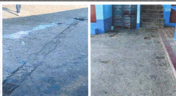
Foto 10: LOSA DE PATIO: Reparación de planchas de concreto de patio. MÓDULO 1
