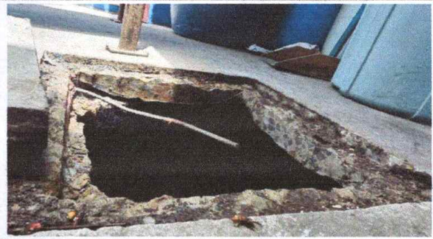
Foto 14: REPARACION DE REDES DE DRENAJE Y FOSA SEPTICA: Reparacion de tapadera de fosa septica, MÓDULO 1
