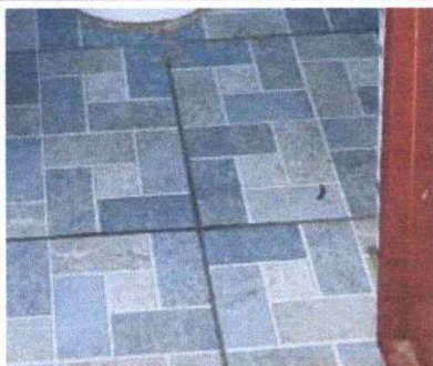
Foto 3: PISO: Sustitución de piso cerámico, MÓDULO 1
