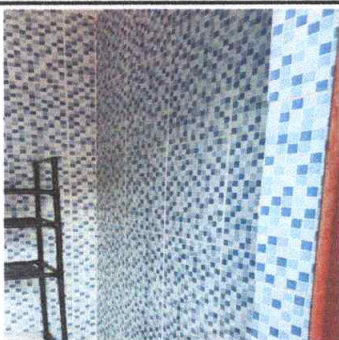
Foto 7: SUSTITUCIÓN DE AZULEJO: Sustrución de Azulejo, MÓDULO 1
