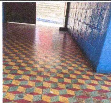
Foto 2: PISO: Sustitución de piso de granito MÓDULO 1
