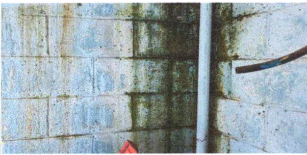
Foto 13: REPARACION DE REPELLO Y CERNIDO DE PAREDES: Repello y cernido en muro, MÓDULO 1
