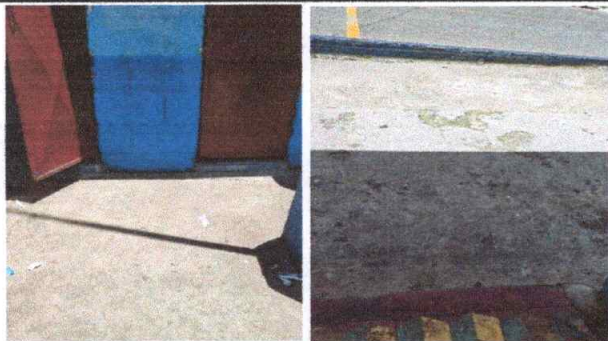
Foto 15: REPARACION DE RED DE DRENAJE Y RED DE AGUA POTABLE, Red de Drenaje, Sustitución de tubería PVC línea principal aguas negras, MÓDULO 1
