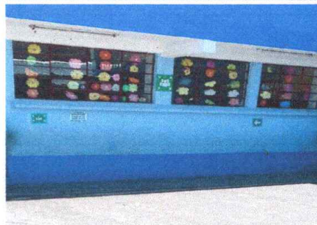
Foto 4: PINTURA EN MUROS EXTERIORES: Pintura en muros exteriores, MÓDULO 1
