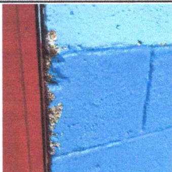
Foto 9: MUROS PERIMETRALES: Reparación de muro perimetral de block. MÓDULO 1
