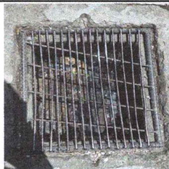
Foto 8: REPOSADERA Y CAJA DE REGISTRO: Sustrución de reposaderas y cajas de registro, MÓDULO 1
